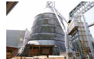
木質バイオマスによる発電施設
